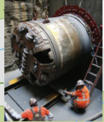
2. Ubicación donde el contratista recuperará la tuneladora después de que termine de excavar.
