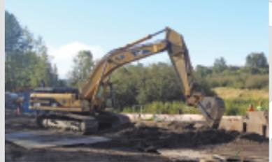
1. El contratista utilizará métodos de excavación con zanja abierta para conectar la nueva tubería de Coal Creek al interceptor del lado este que lleva a la planta de tratamiento del sur. Inmediatamente después se restaurará el paisaje.
