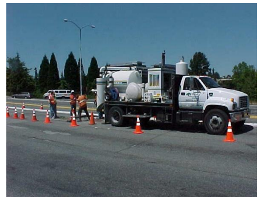
例：用于公共设施定位的真空挖掘机
