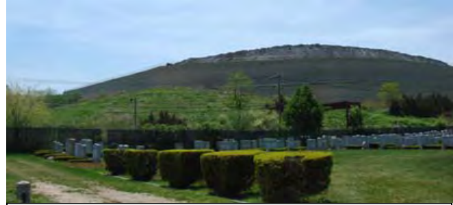
New York Landfill Walls
