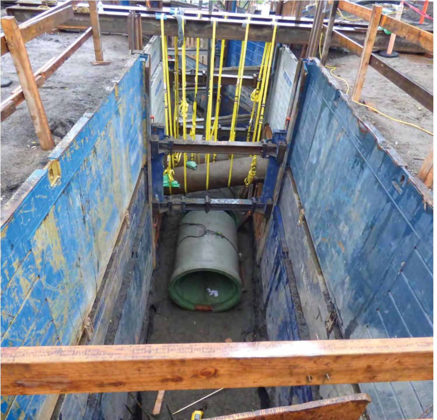
(/img/oge3ji4ukchhokf27c1e\_1235\_1200.JPG)Instalación a cielo abierto de una tubería de 60 pulgadas.
