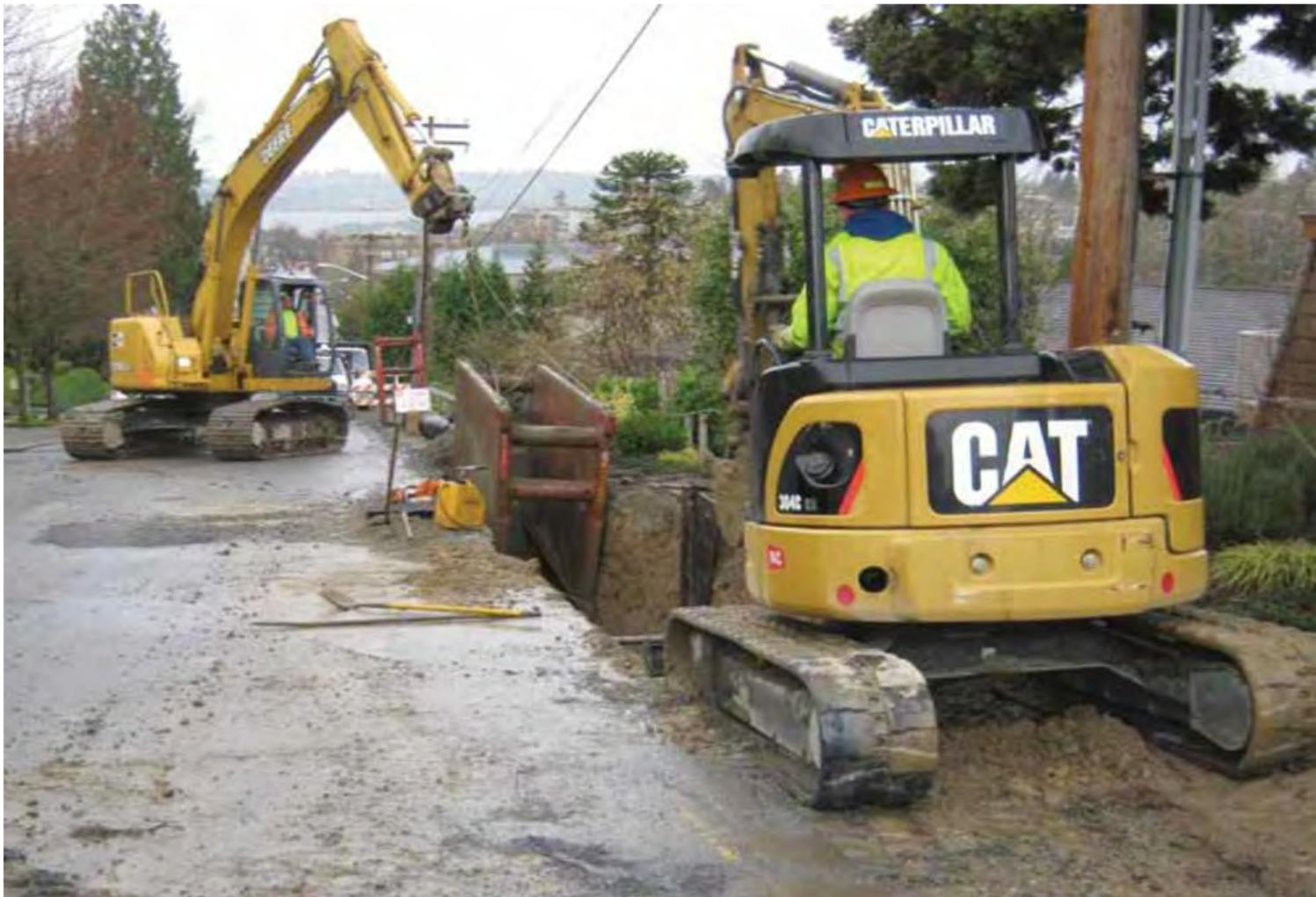
*(/img/nsiacouapv9ru0cyqo5l\_1600\_1105.JPG) Los equipos excavan antes de la instalación a cielo abierto.*
