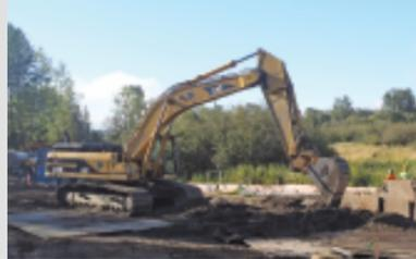
1. 承包商用挖明沟的方式连接新的 Coal Creek 管道至 East Side Interceptor 截留管，然后排入 South Treatment Plant，随后修复地面植被。
