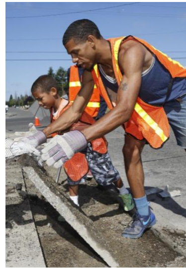
Una familia retira pavimento innecesario que se reemplazará por alternativas hidrófilas.
