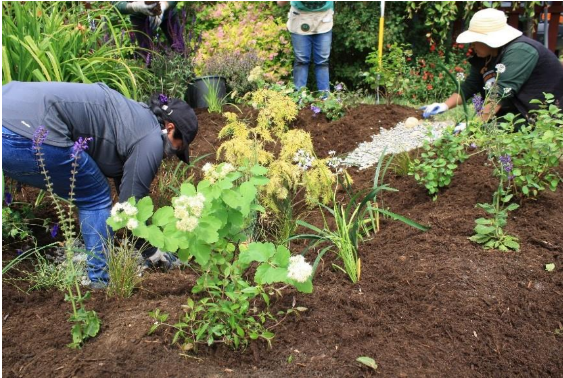
Personas trabajan juntas para construir y plantar un jardín de lluvia.
