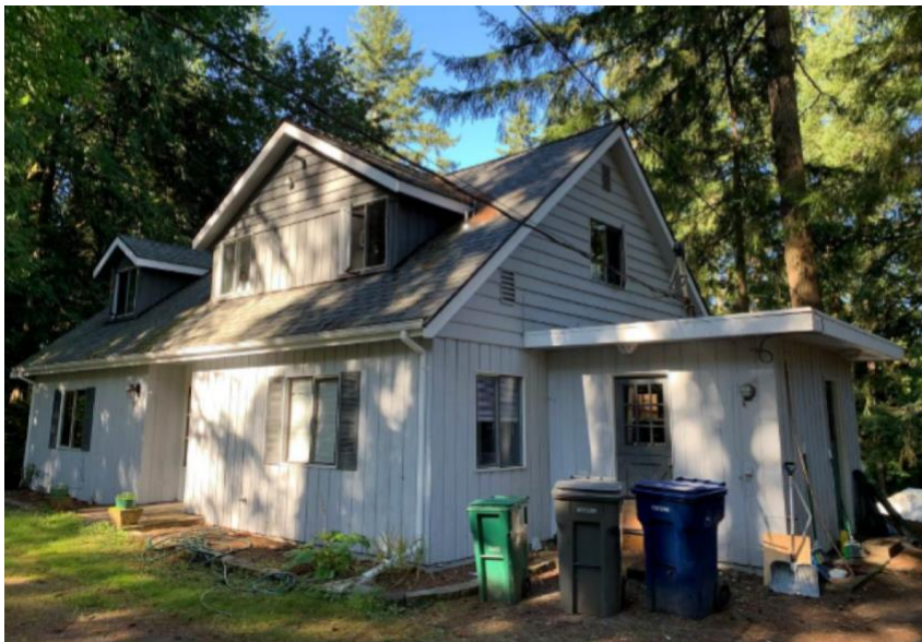
Una vivienda en Redmond, Washington en la que se instalará una cisterna.
